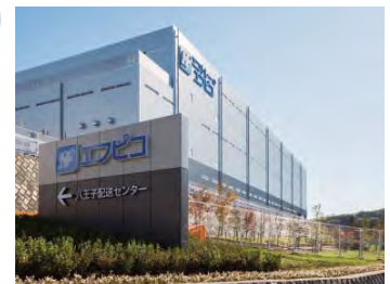
八王子配送センター
