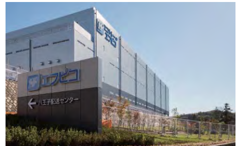
八王子配送センター
