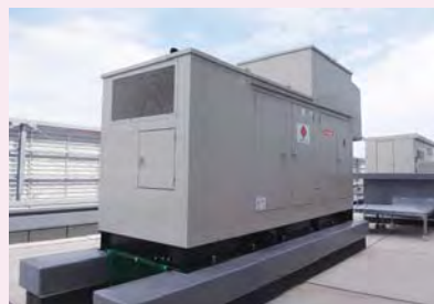
八王子配送センター
