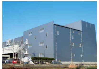
光学機能性フィルムの新工棟(新宮事業所)
