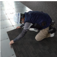
タイルカーペット施工の様子
