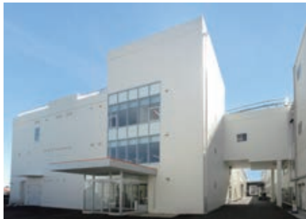
*2020年8月には工場棟の増築工事も完成し、生産能力がさらに拡大します。
