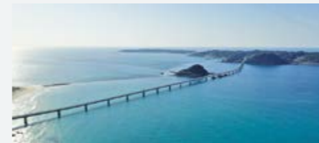
オリエンタル白石(株)が施工した角島大橋(土木学会デザイン賞、PC技術協会賞受賞)
