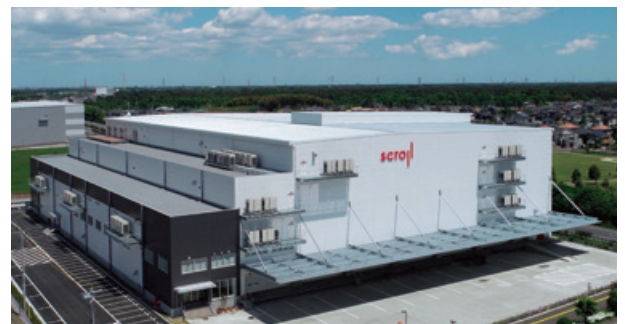
▲スクロールロジスティクスセンター(SLC)みらい
