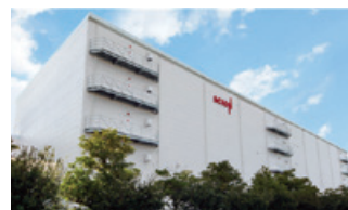
スクロールロジスティクスセンター浜松西
