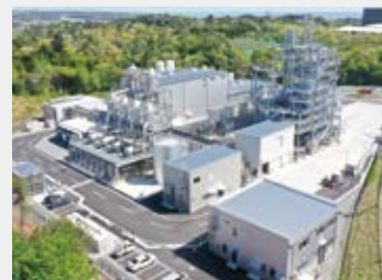
建設中の豊通リチウム楡葉工場
