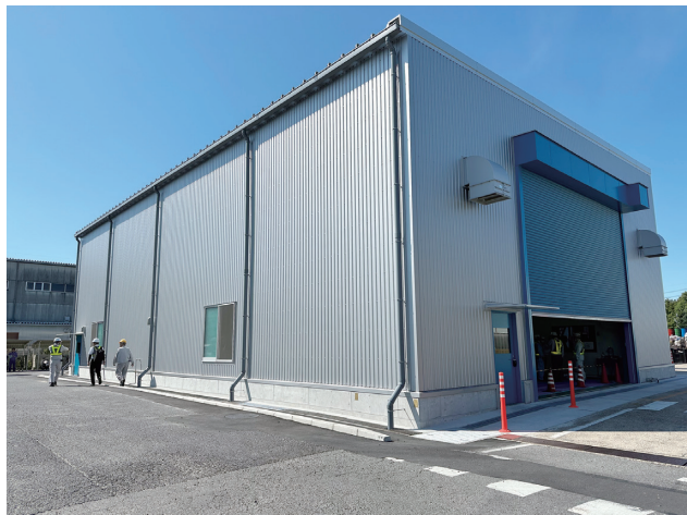
電池リサイクルの建屋(豊田ケミカルエンジニアリング(株)内)
