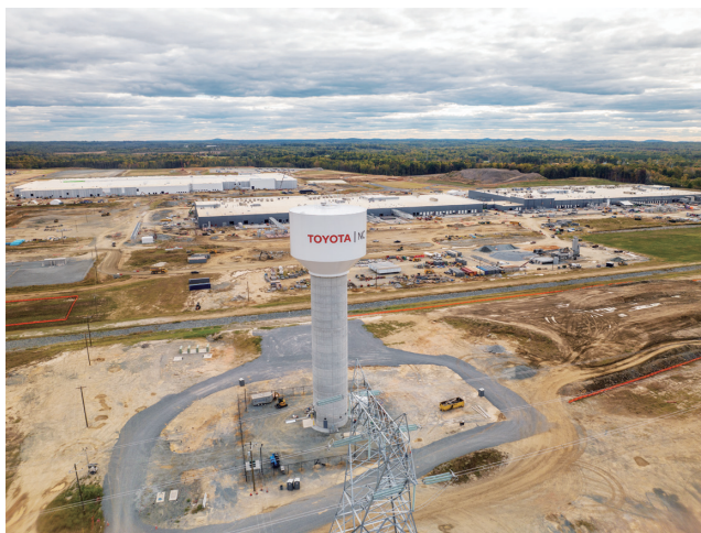
建設中の電池工場
