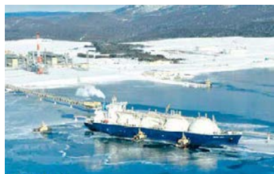
サハリンII LNGプロジェクト ©Sakhalin Energy
