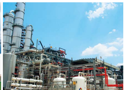
米国 Fairway Methanol 社製造工場
