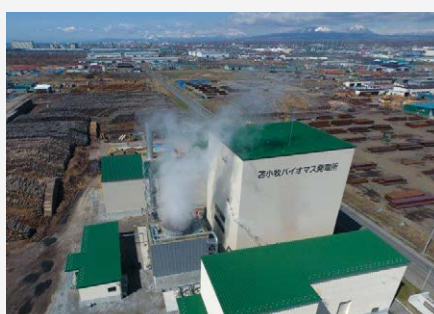
苫小牧バイオマス発電
