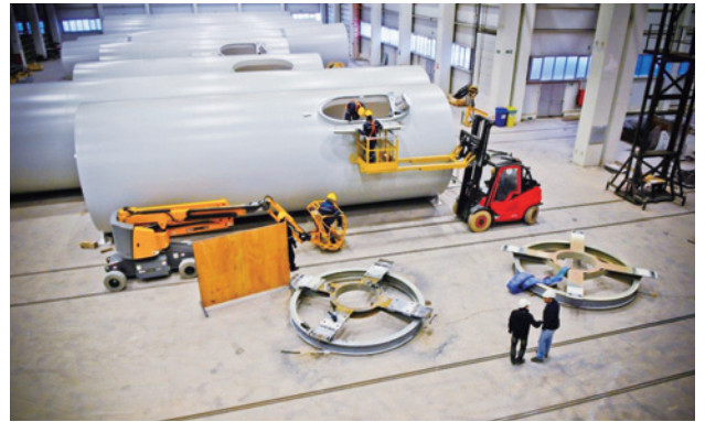
製造中の風力発電用タワー
