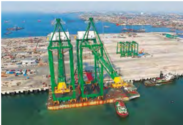
建設中のタンジュンプリオク港の沖合コンテナターミナル
