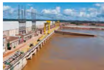
ジラウ水力発電所
