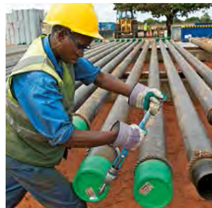
モザンビークLNG作業風景
