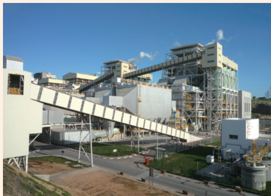
エルジャディダ市近郊のジョルフ・ラスファール発電所
