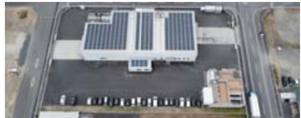
SMP阿久根工場加工センター 太陽光発電設備
