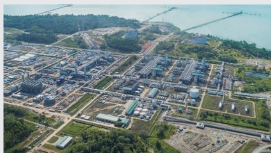
液化プラント既存第2系列および建設工事の拡張系列、LNGタンク、棧橋等
