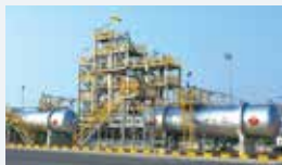
ブルネイ水素化プラント
