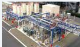
川崎脱水素プラント
