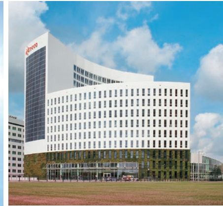
▲オランダ・ロッテルダムのEneco本社 ▲Eneco保有の風力発電設備
