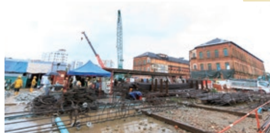
雨季の長いヤンゴンでは、大雨で作業の一時中断は日常茶飯事だが、緻密な計画を立て、スケジュールどおりかつ安全に作業を遂行中
