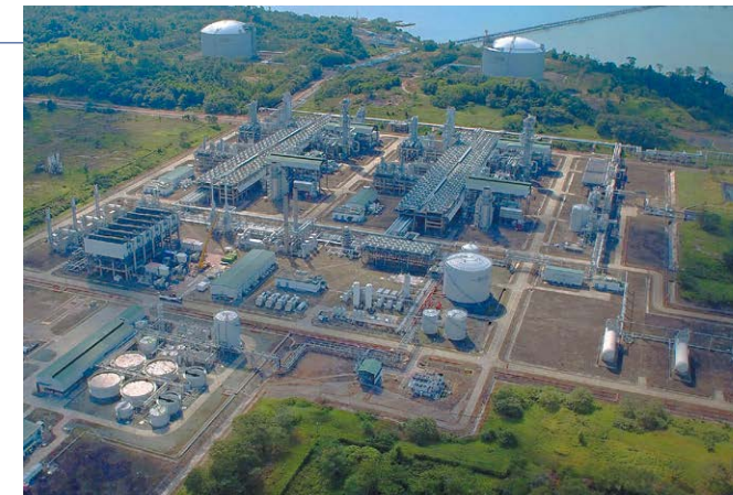
既存の液化プラントとLNGタンク、棧橋 (2016年第3四半期より拡張工事着工予定)
