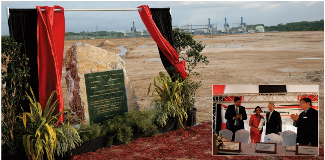
■建設予定地／くわ入れ式の様子
