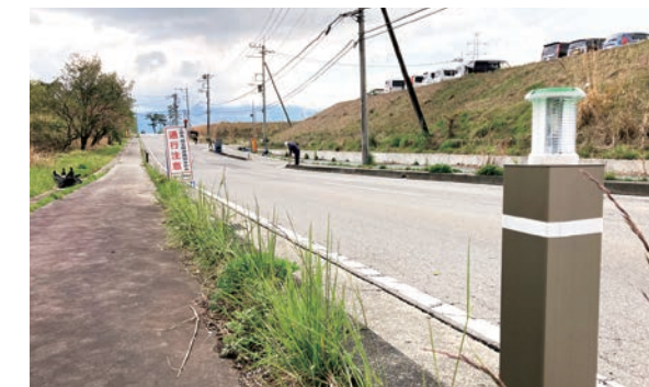
静岡県小山町に設置されたキヅキミライボラード。「雨天時道路冠水の為『通行注意』」の看板が見える。
