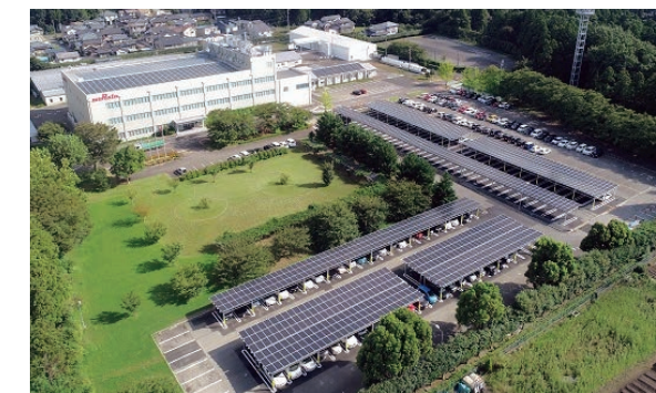
蓄電池とエネルギー管理システムを組み合わせ、系統電力の供給負荷を低減している。
