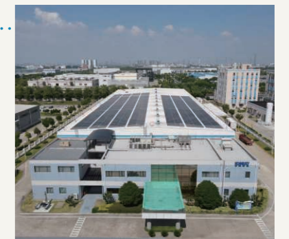
太陽光パネル発電設備
