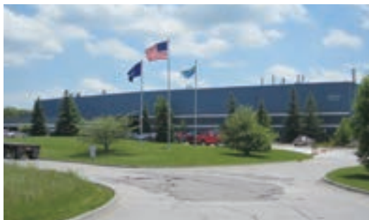
GBP入口正面の様子
