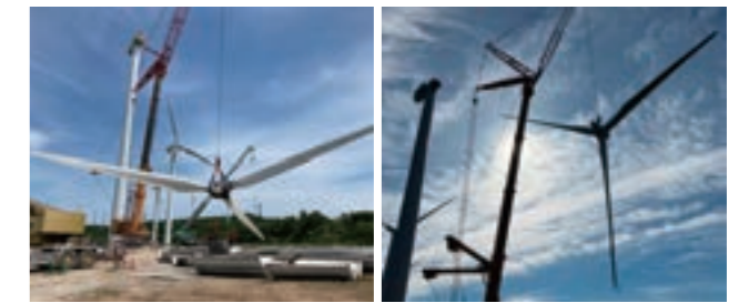
風力発電の解体
