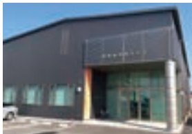
亀井鐵鋼(株)外観
