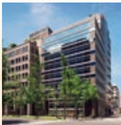
WAKITA 藤村御堂筋ビル
