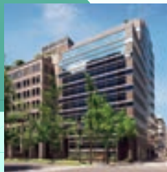
WAKITA 藤村御堂筋ビル
