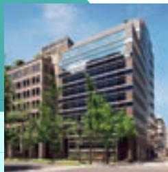
WAKITA 藤村御堂筋ビル
