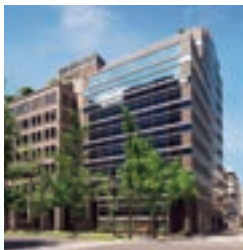
WAKITA 藤村御堂筋ビル
