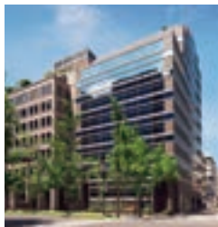
WAKITA 藤村御堂筋ビル
