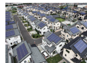
太陽光発電システム
