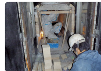
専任エンジニアが火葬炉設備の修繕作業を行えるため、速やかに緊急対応ができます
