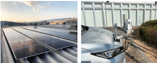
工場屋根上に50kWパネルを設置 V2Hシステムによる電気自動車充電
