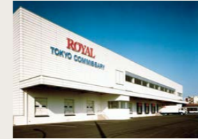
東京食品工場(竣工当時)
