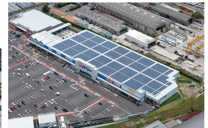
パワー店舗屋上のソーラーパネル
