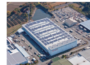
流通センター屋上のソーラーパネル
