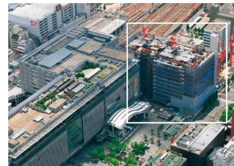
建設中の建物は「博多マルイ」が出店する日本郵便株式会社さまの「KITTE博多」。左は隣接するJR博多シティ(2015年5月)
