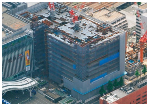
建設中の建物は「博多マルイ」が出店する 日本郵便株式会社さまの「KITTE 博多」(2015年5月)
