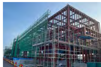
工事中のデリカ工場
