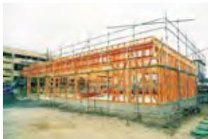
工事中の店舗
