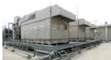
自家発電設備の設置
