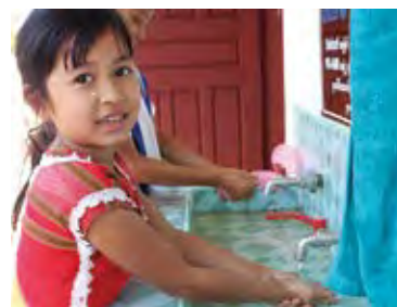
安全な水が使える手洗い場を設置(ミャンマー)
