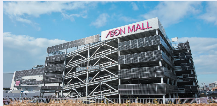
2018年3月オープン「イオンモール座間」では1000KWの太陽光発電設備を導入
