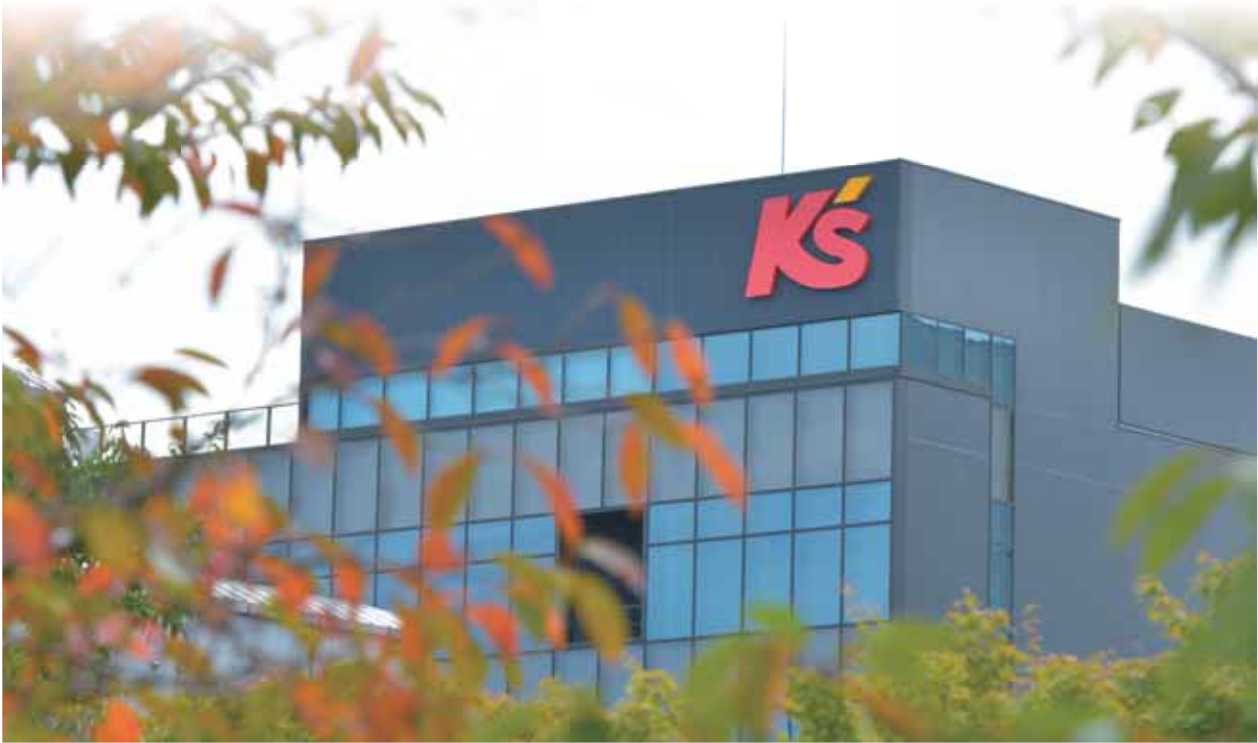
2022年8月竣工 ケーズホールディングス新本社
