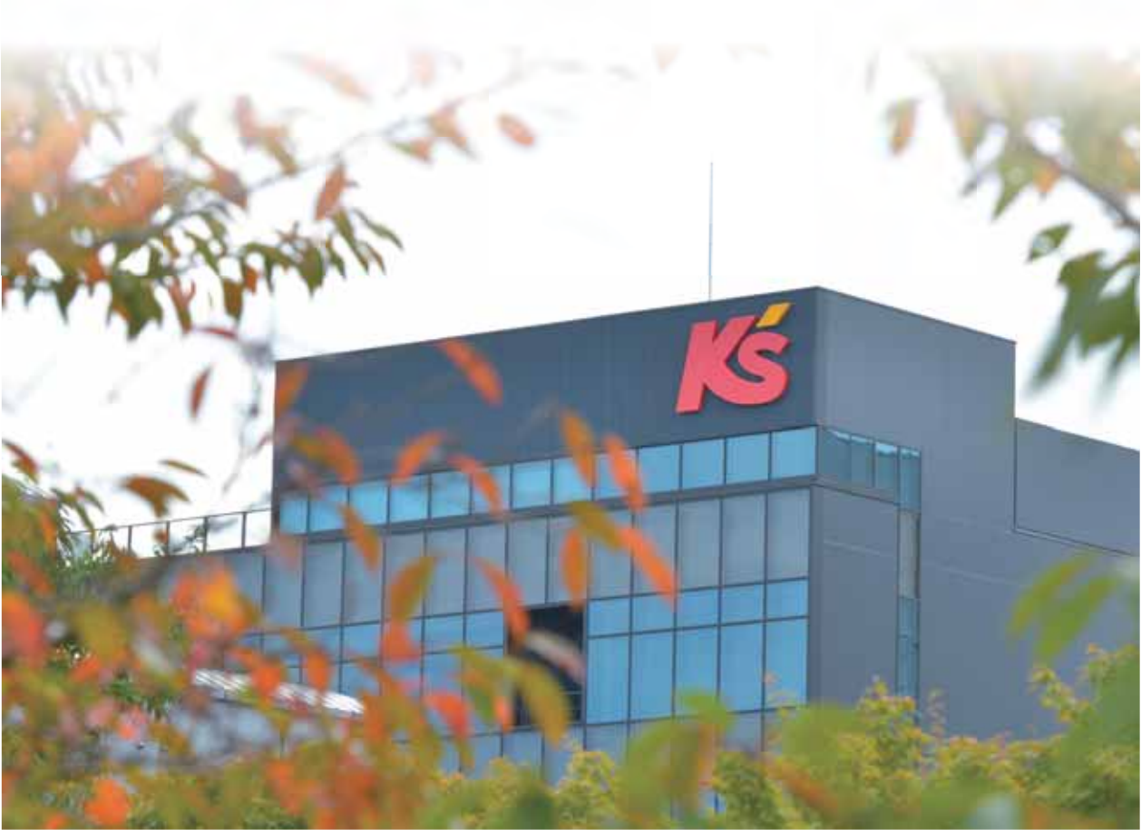
2022年8月竣工 ケーズホールディングス新本社
