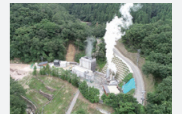
すでに商業運転を開始している第一発電所
