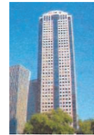
上海駐在員事務所入居ビル
