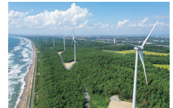
A-WINDかたがみ風力発電所
