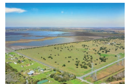
テキサス州 太陽光発電所
