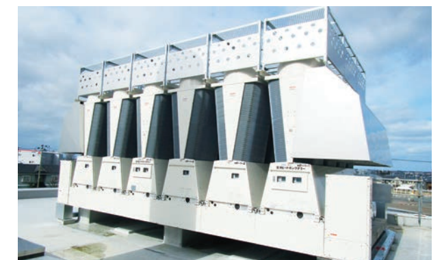
ESCOサービスで導入した空冷ヒートポンプチラー(空調用熱源機器)
