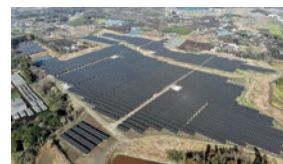
袖ヶ浦太陽光発電所
