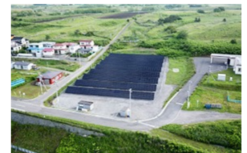
函館市太陽光発電施設
