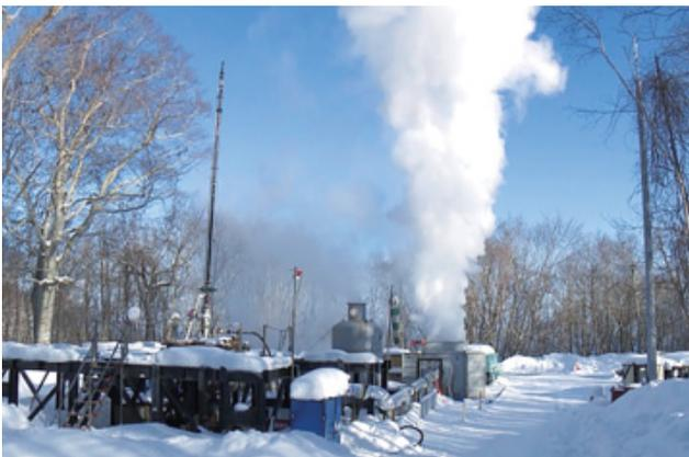
函館市南茅部における掘削現場（地熱発電所建設に向けて調査中）
